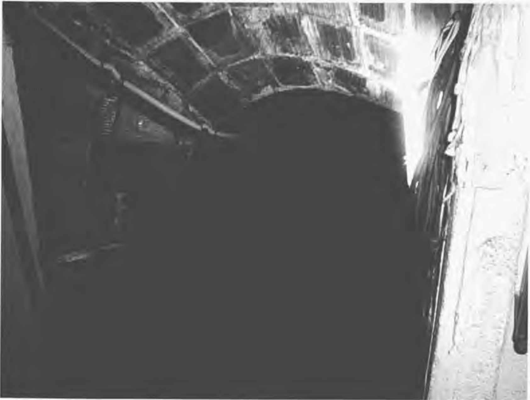
Interior d'un dels refugis de la Guerra Civil (fotografia: J. Tarragó, 2004).
